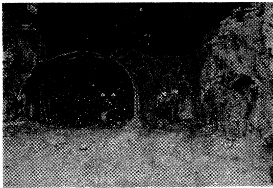
図-9 導坑支保工と大背掘削
